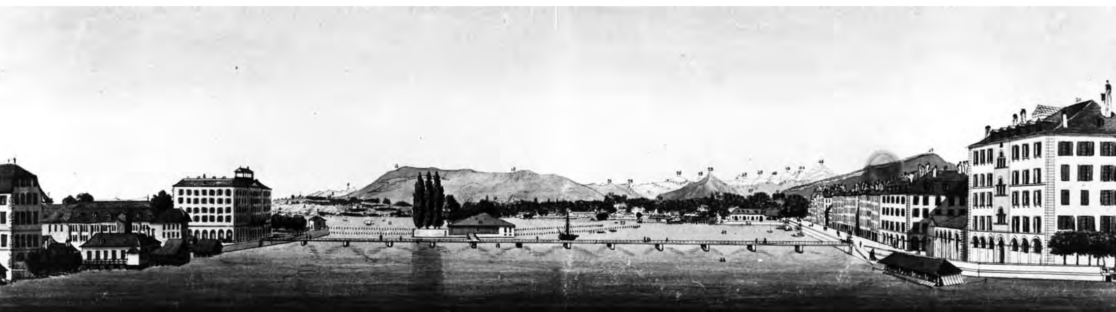
Quant au plus minutieux des dessinateurs genevois, Jean DuBois, il donne l'ultime vision de la petite rade avec l'Île des Barques avant les transformations par l'ingénieur Guillaume Henri Dufour en 1834-1835. Le pont des Bergues est en place mais sans sa rotonde, l'Île des Barques aussi, l'hôtel des Bergues est bien visible, rien ne présage encore l'arrivée imminente d'un Jean-Jacques en toge de bronze.
